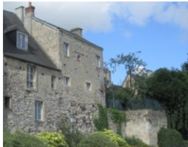
C) Parking des remparts
