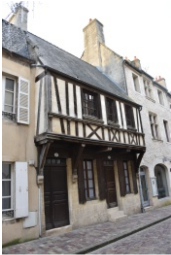
B) Maison à pan de bois 20 rue des Cuisiniers
