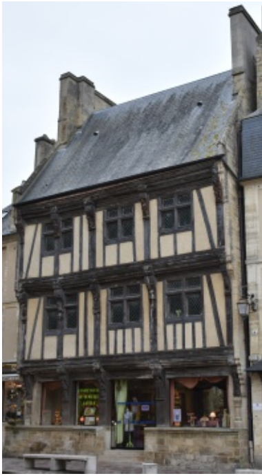
A) Maison d'Adam et Eve - vue générale 6 rue du Bienvenu
